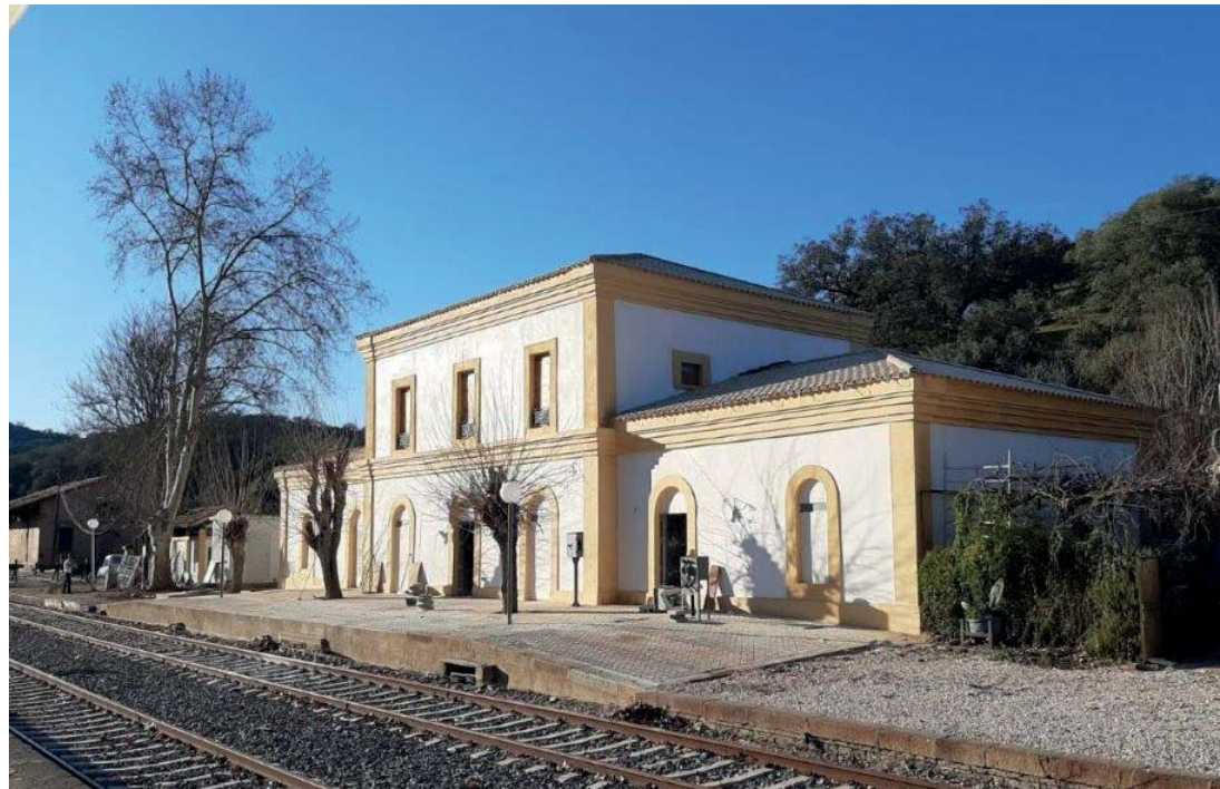
Rehabilitación estación de ferrocarril Cazalla de la Sierra (Sevilla).
