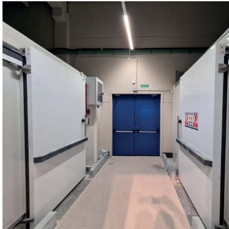
Construcción de nave industrial en Écija (Sevilla).
