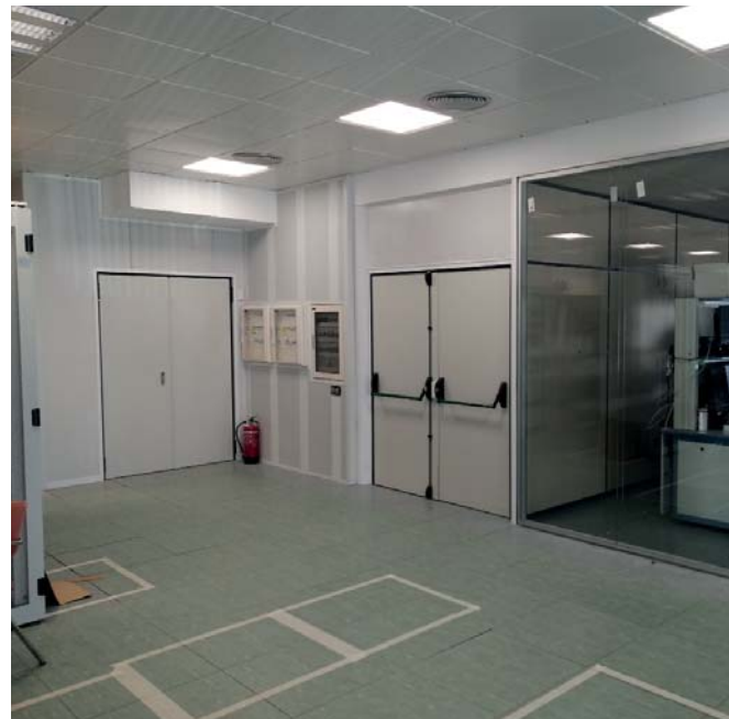
Ampliación de sala de equipos de simulación ENAIRE, Sevilla.
