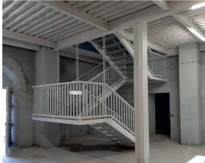
Rehabilitación de edificio, Sevilla.
