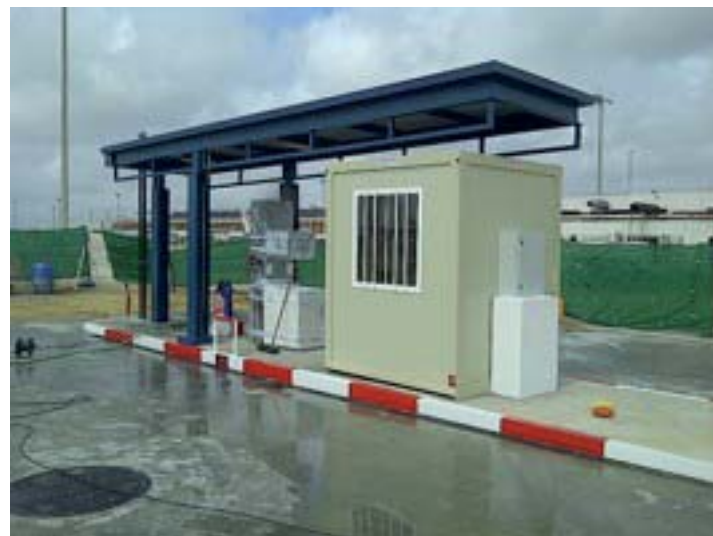
Estación de servicio de combustible, Sevilla.
