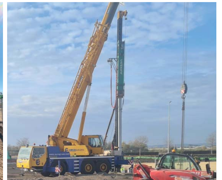
Pilotes prefabricados, San José de la Rinconada (Sevilla).
