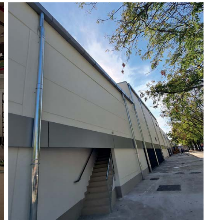
Construcción de nave industrial, Sevilla.
