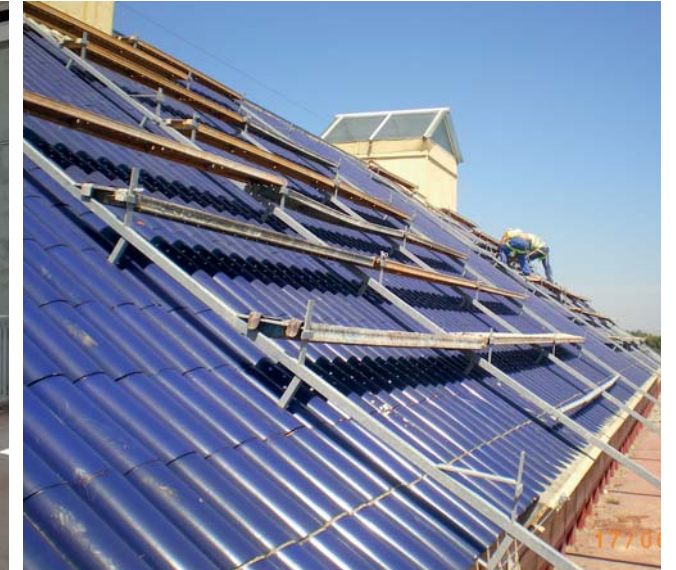
Rehabilitación de cubiertas, Sevilla.
