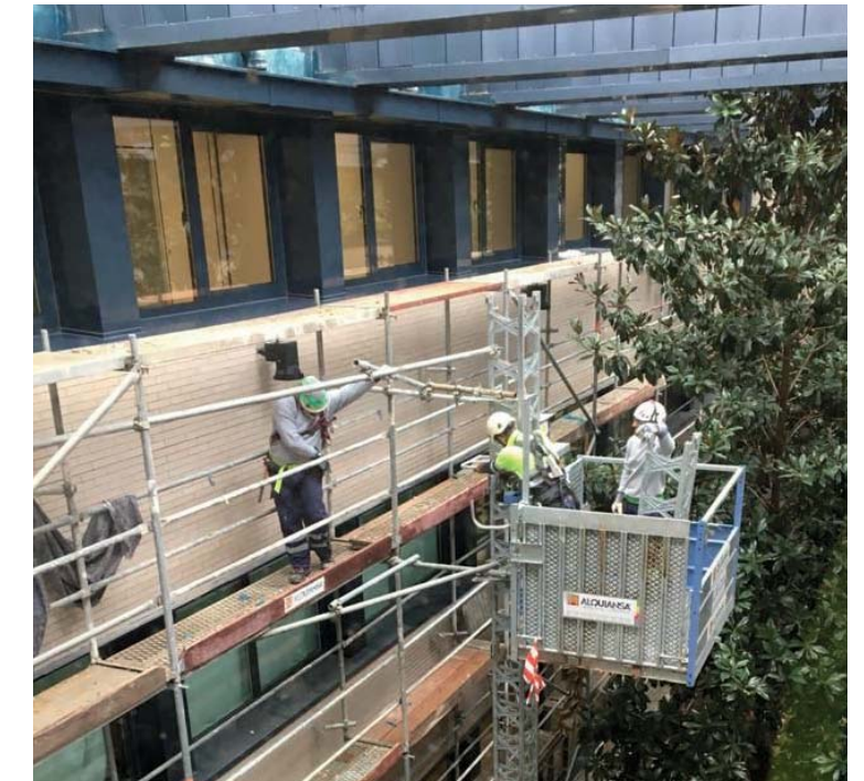
Rehabilitación de edificio, Sevilla.
