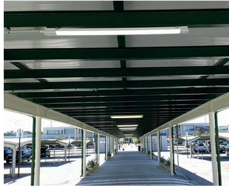
Estructura metálica en Aeropuerto de Jerez de la Frontera (Cádiz).
