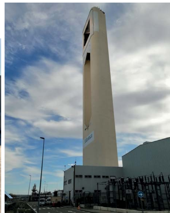
Instalación suelo técnico en Planta Solar Solucar.
