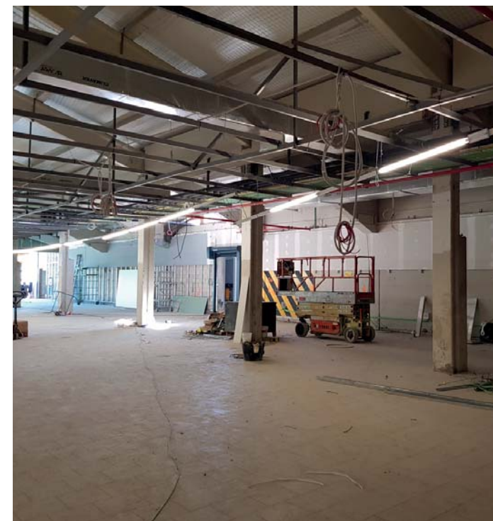
Construcción de nave industrial en Aracena (Huelva).
